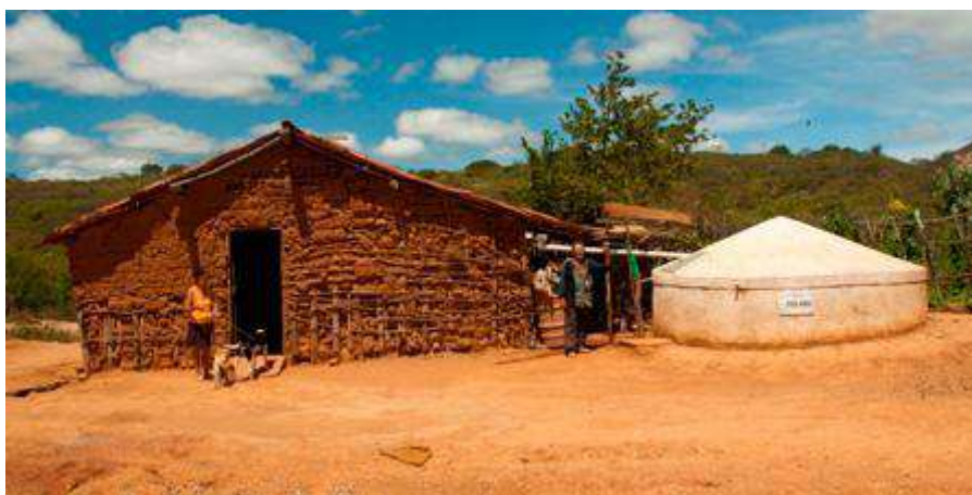
Figura 2 - Cisterna de placa.
