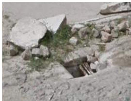
PV de esgoto aberto p/ escoamento de águas pluviais
