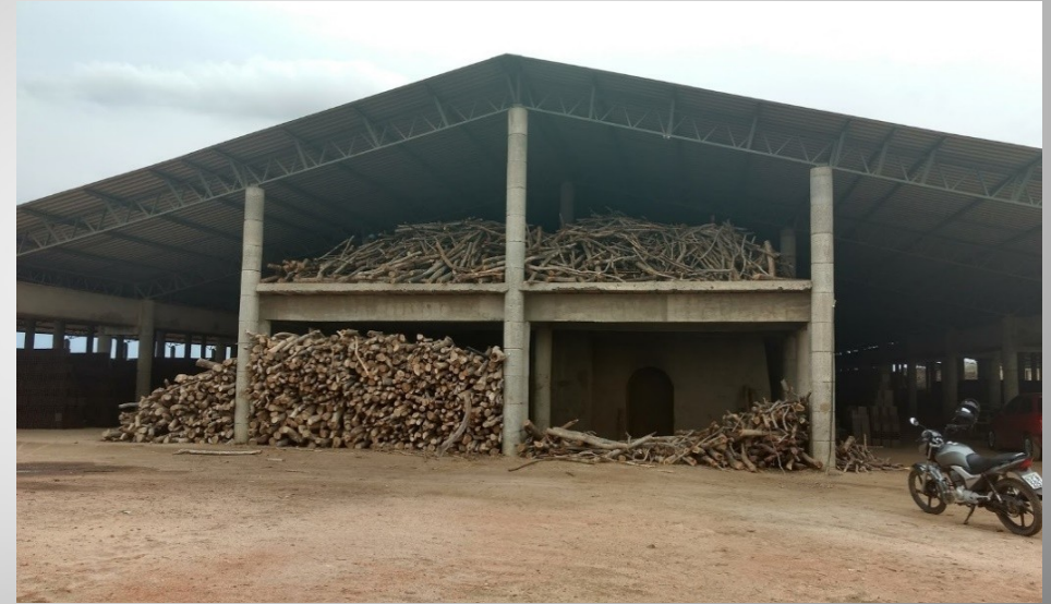
Utilização de madeira em olarias locais próximas à Barragem Araras
