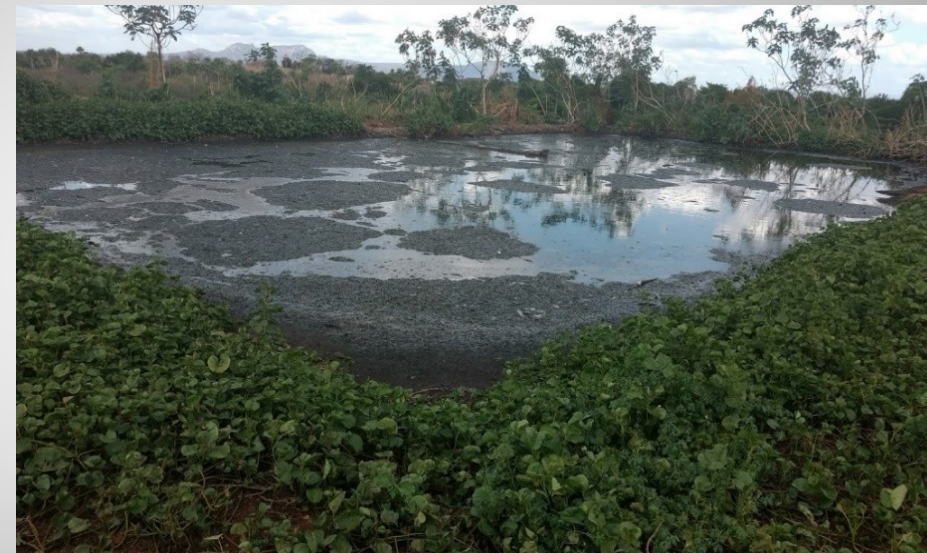
Lagoa de estabilização construída sem impermeabilização e sendo operada de maneira ineficiente
