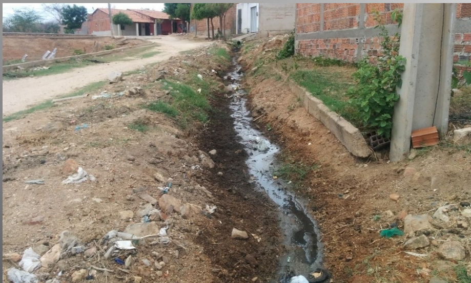
Lançamento de efluente doméstico a céu aberto próximo ao Barragem Araras
