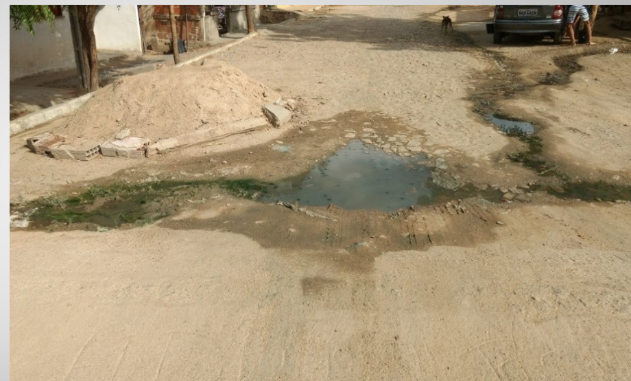
Lançamento de efluente doméstico a céu aberto na bacia hidrográfica da Barragem Araras
